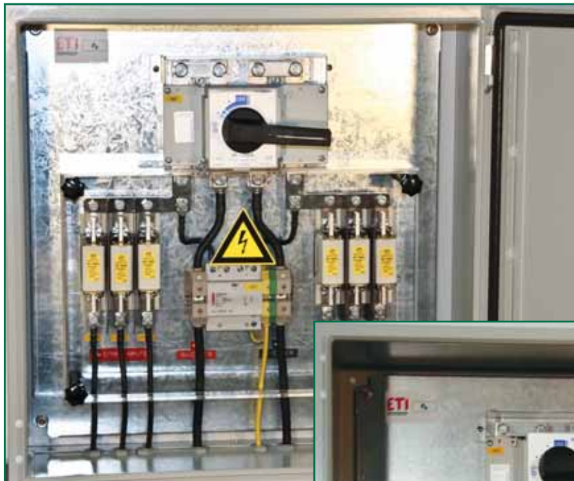
Rozdzielnica DC (wkładki NH gPV)
